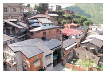
九份和金山的傳統房舍為什麼有「黑屋頂鋪油毛氈」？為了應付東北季風，隔絕溼氣所鋪設的材料。
